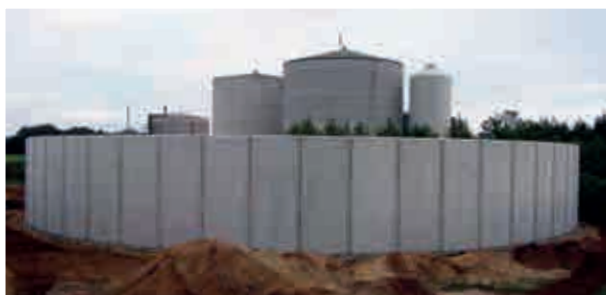
Période d'installation du réservoir rapide.
