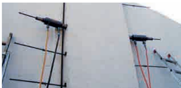
Construction robuste – câble de mise en tension internes en acier à haute résistance
